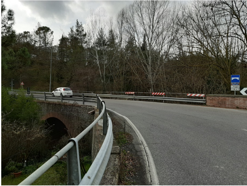
4. PONTE SP 302R PK 77+448 SUL LAMONE, LOC. S. EUFEMIA
